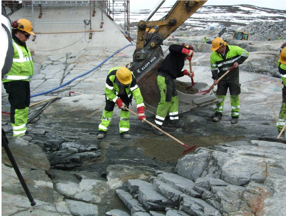
Bilde 5 - Preparering av damfundament. Noen ganger er det bare h  ndarbeid som duger. (Bilde: E-CO Vannkraft AS)
