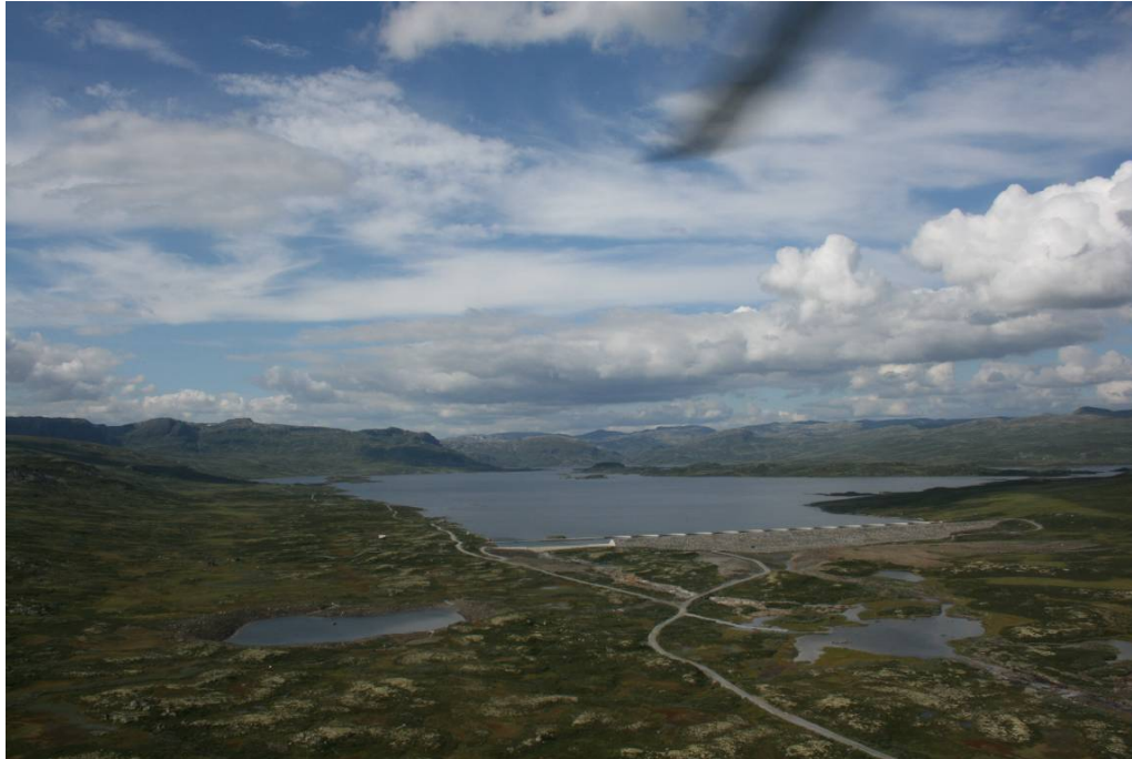
Bilde 1 – Ny steinfyllingsdam med den gamle flerbuedammen bak. Steinbruddet her blitt "Bruddtjern" - nede til venstre mens arrondert moreneuttak kan skimtes på dammens luftside til høyre i bildet. (Bilde: E-CO Vannkraft AS)
