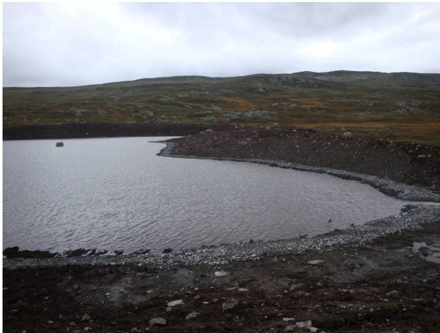
Bilde 2 - Steinbrudd tilrettelagt for naturlig revegetering. Ca 300 000 m3 stein er tatt ut. Gir plass for mye vann og fine fisker. (Bilde: E-CO Vannkraft AS)
