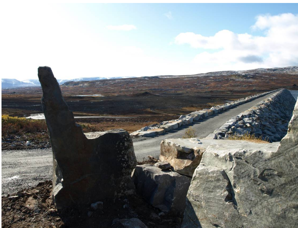
Bilde 4 - Ny dam Stolsvatn med nedsenket veibane i damkrona. Navnet Stolsvatn kommer fra fjellet Stolsnuten. (Bilde: E-CO Vannkraft AS)
