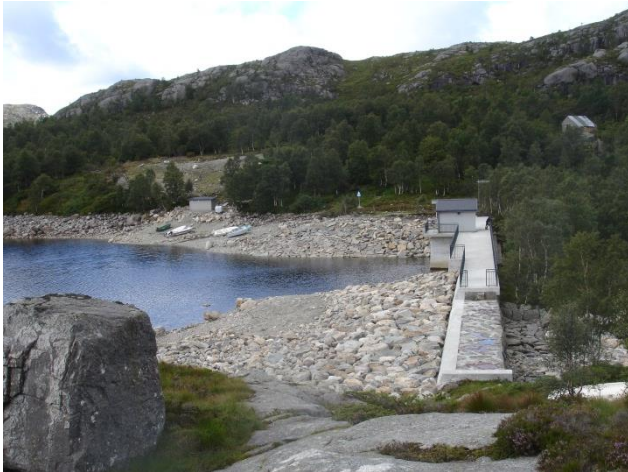
Svortingsvatn dam etter rehabilitering
