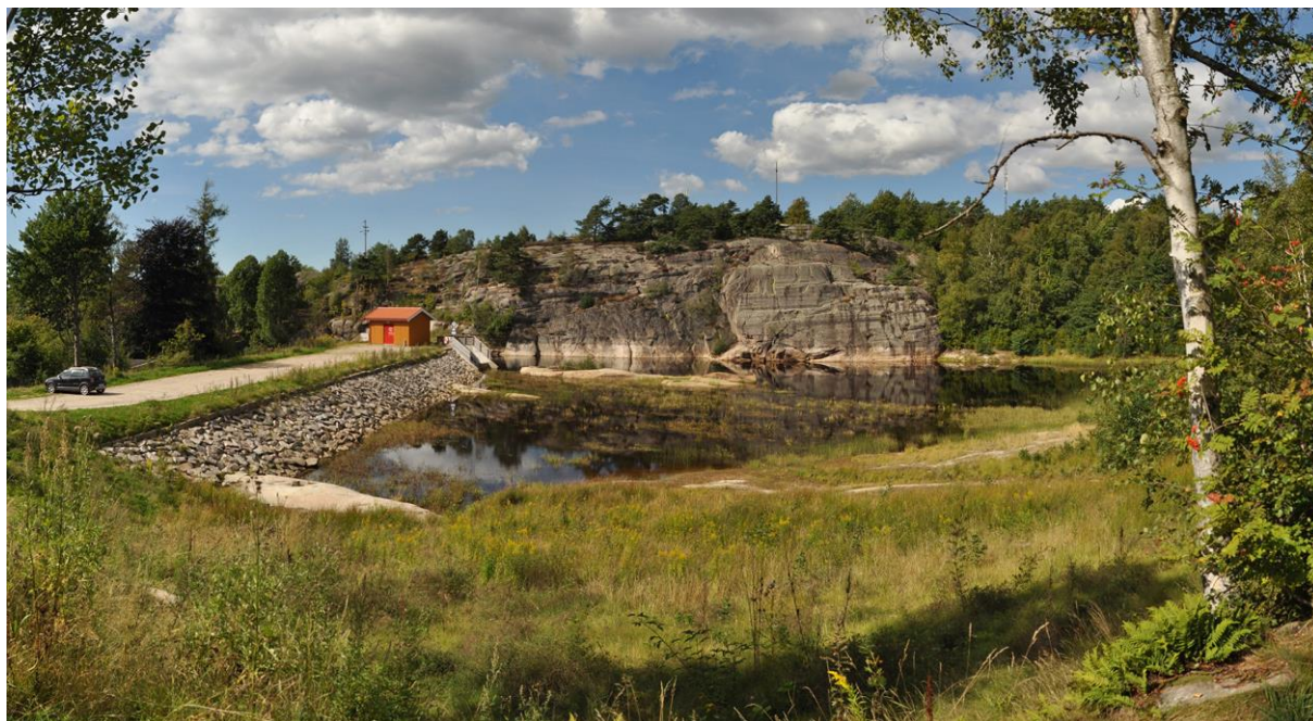
Bilde 1. Ved nedre dam vart eksisterande vasstand senka med 1 meter for å redusere påbygging av dammen.
