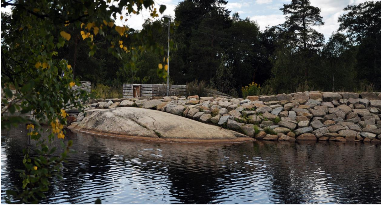
Bilde 4. Biletet syner omtanken ein har hatt for eksisterande landskap med nøye tilpassing av nye konstruksjonar.
