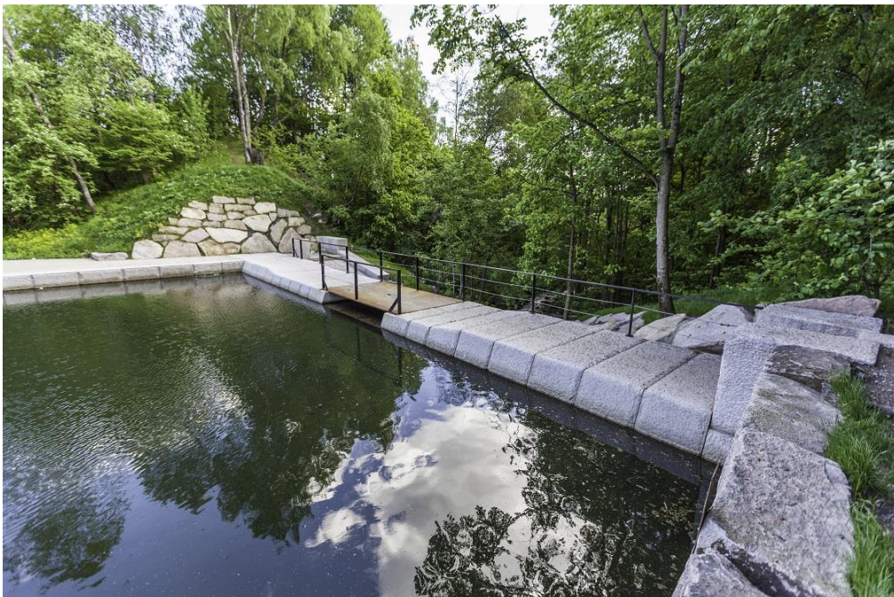
Figur 6. DAMKRONE OG UTLØP FRA GRORUDDAMMEN (Foto: Thomaz Majewski for LINK landskap)
