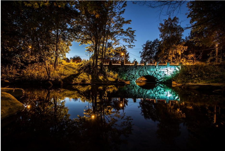
Figur 1. NEDRE KALBAKK BRU (Foto: Thomaz Majewski for LINK landskap)
