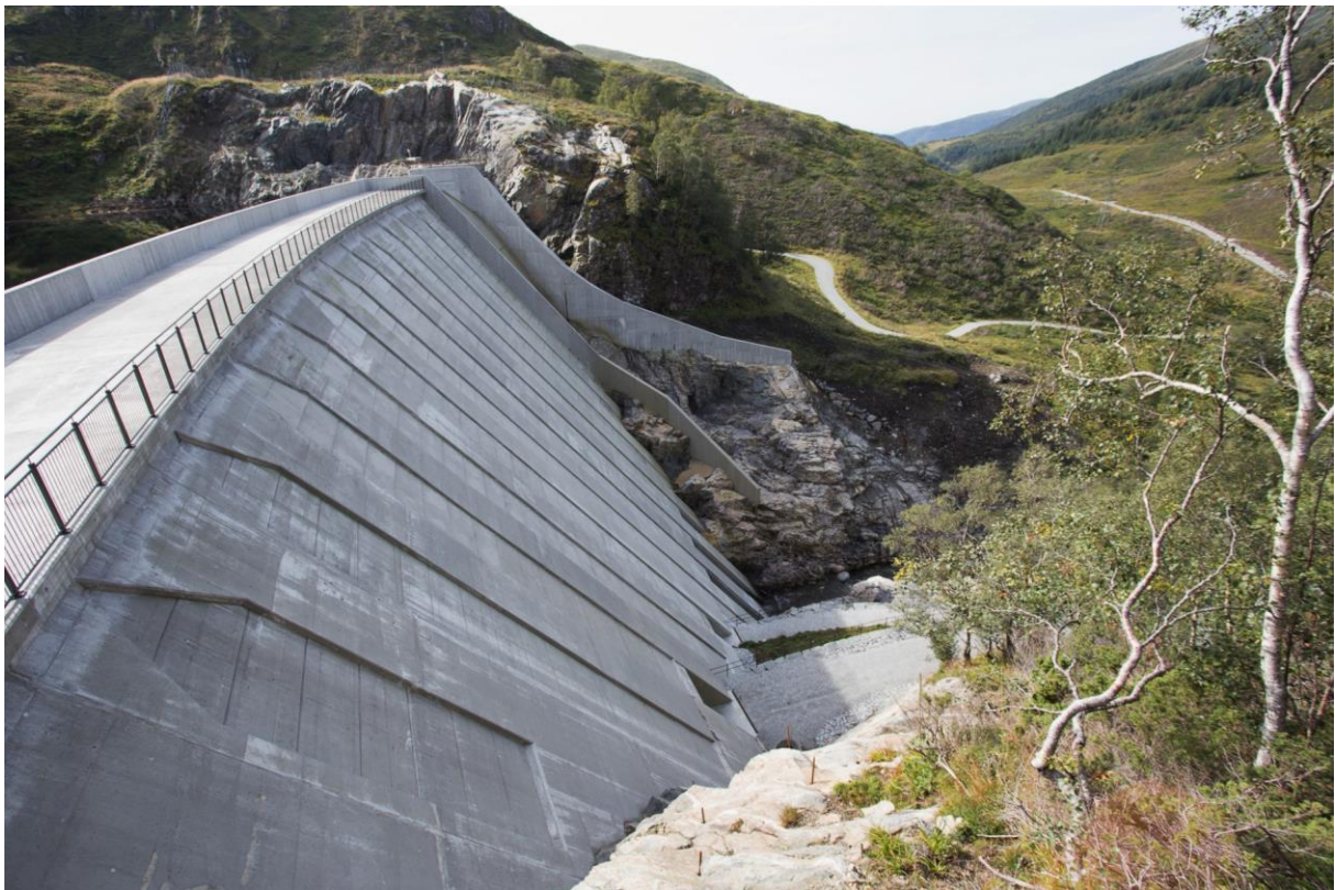
Figur 4. Luftsiden av dammen og utsyn mot nedstrøms terreng.
