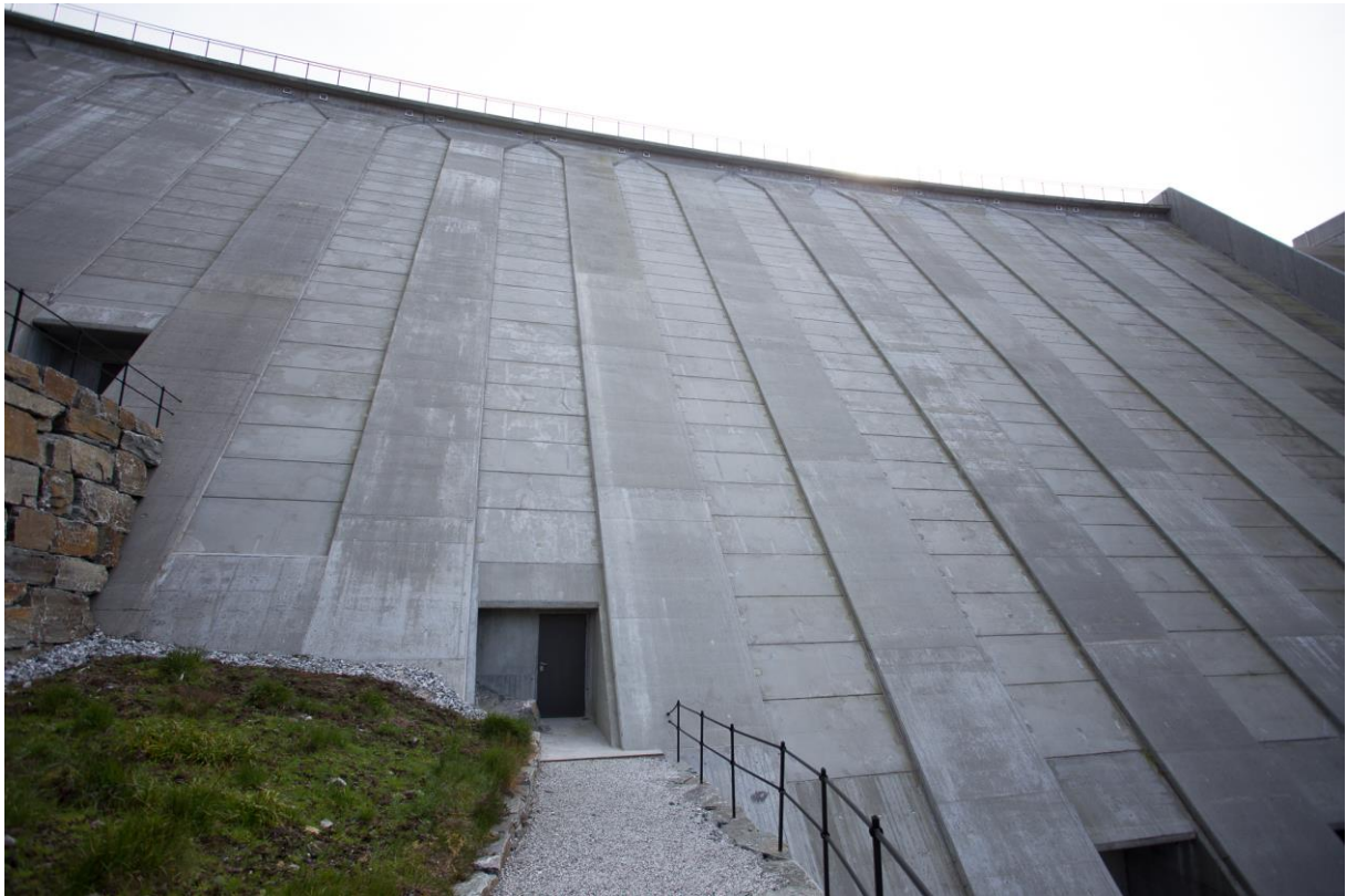
Figur 2. Luftsiden av dammen med nedsenket frostvegg mellom lamellene.
