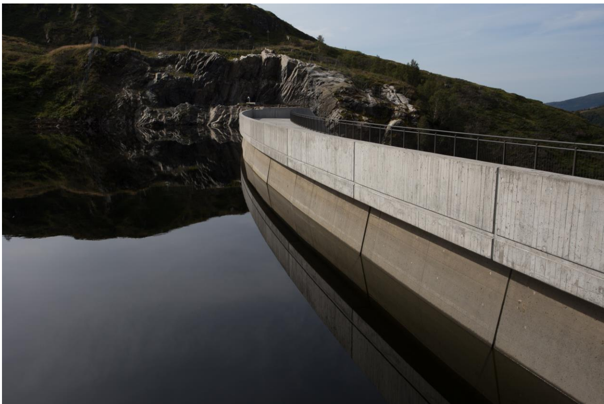
Figur 5. Vannsiden av dammen er buet inn i magasinet.
