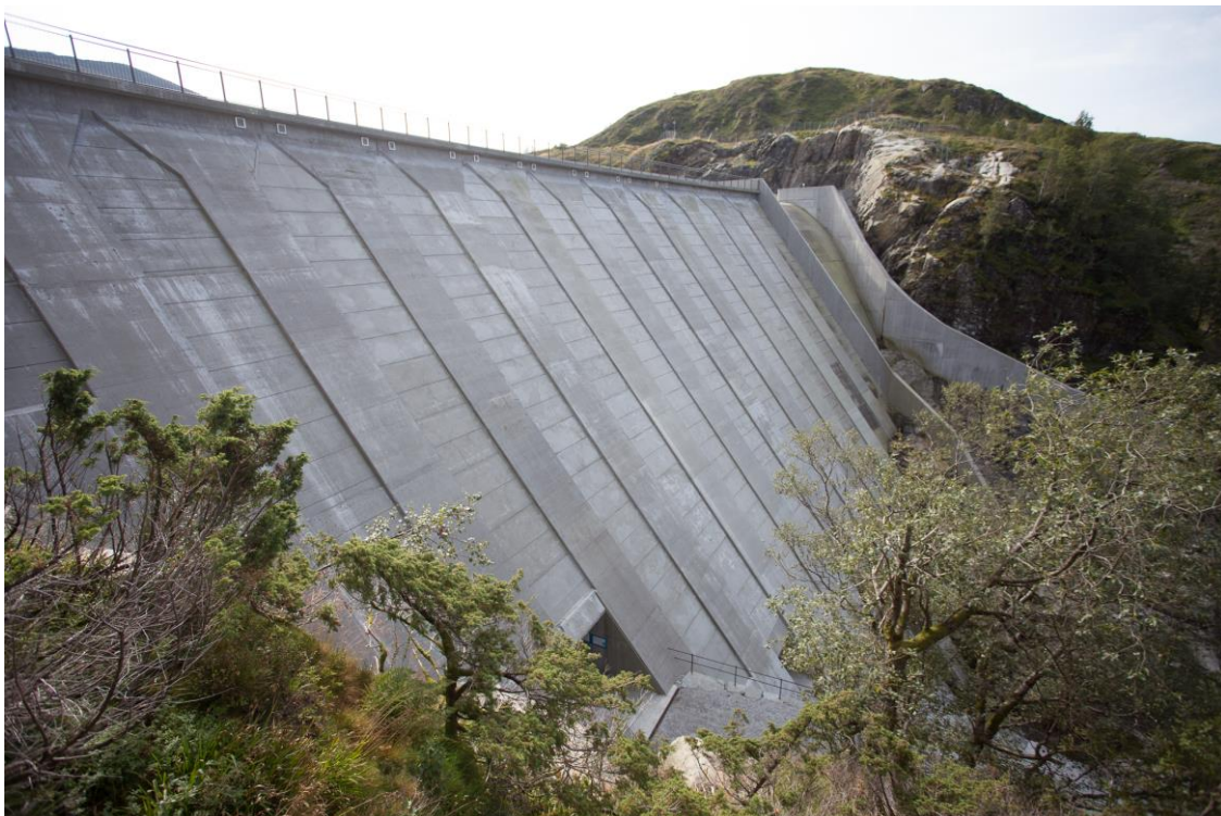
Figur 3. Luftsiden av dammen med nedsenket frostvegg mellom lamellene.
