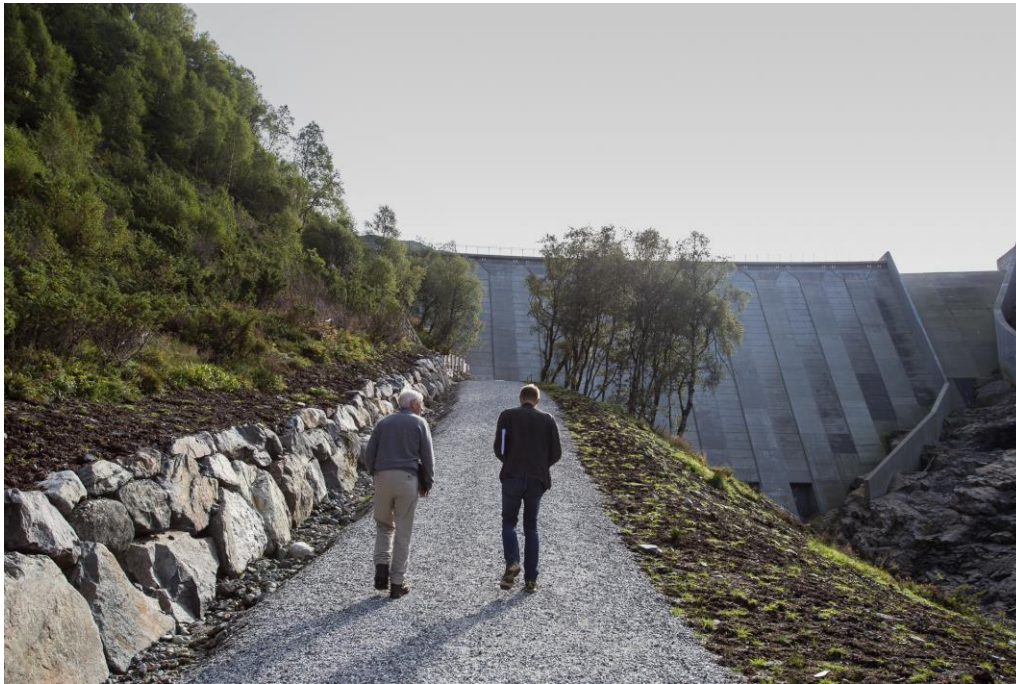
Figur 1. Ny gangsti opp til dammen. Flomløpet til høyre i bildet.
