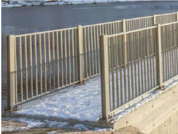
Rekkverket montert på dammen sett fra nord.
