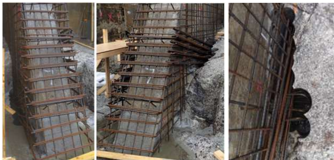
Flere bilder av armering. Her ved pilar 7 der gropene er plassert forskjøvet på grunn av fjellets utforming.
