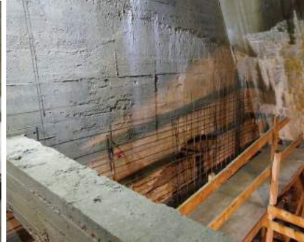
Til høyre -fra en pilar mot damplate der det gjøres reparasjon
