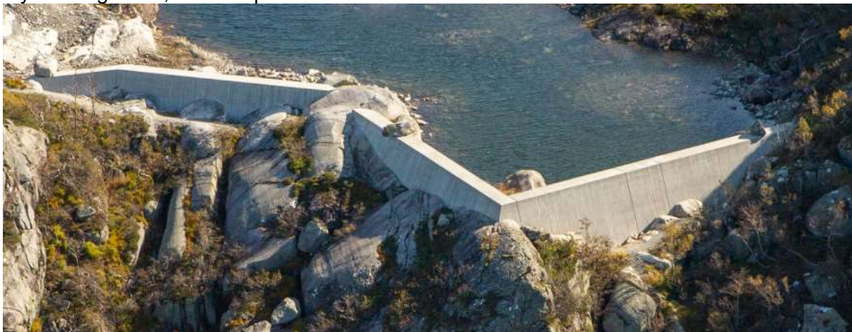
Oversikt over Atthaldsdammene, ferdig rehabilitert.
