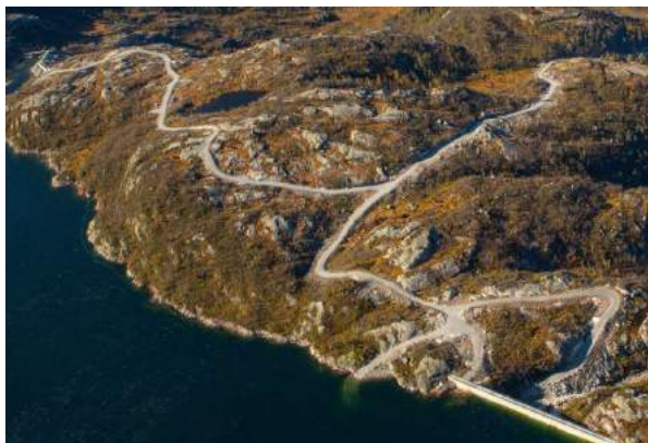
Veien øvre del ved dam Finnflot og mot Atthaldsdammene
