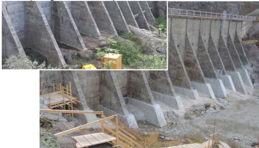
Pilarer mot fjell – opprinnelige og groper/fundament ferdig støpt.
