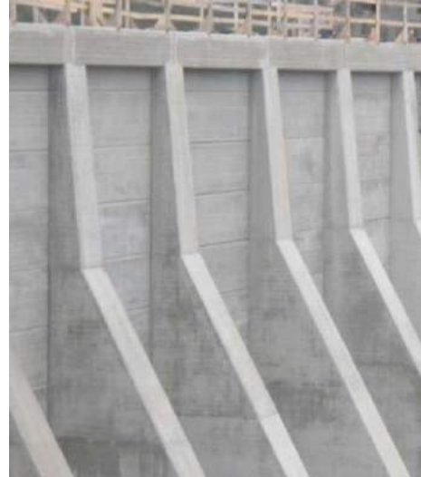
Reine nye betongoverflater uten staghull
