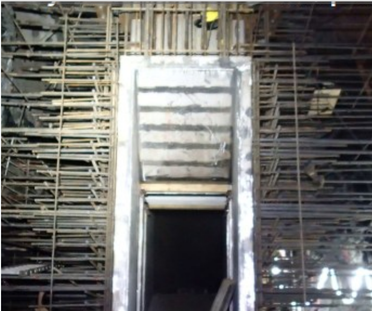
Nytt tappearrangement i omløpstunnel
